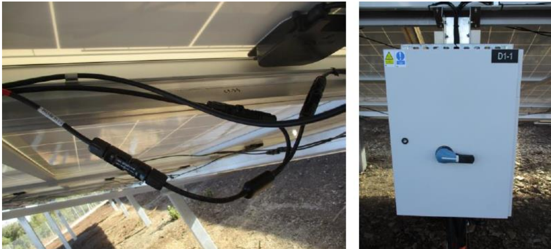
Figure 10: Exemple de câble électrique et de boîte de raccordement - Q ENERGY France
