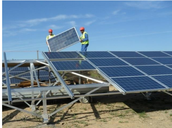
Figure 12: Exemple de mise en place des panneaux sur les structures - Q ENERGY France
