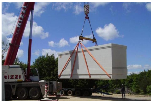
Figure 14: Installation d'un poste électrique
