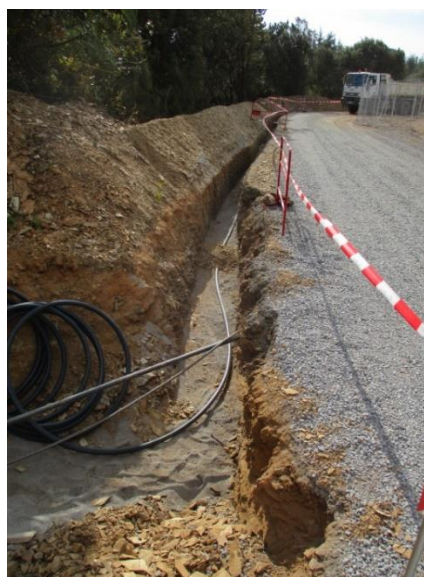
Figure 13: Exemple de tranchée en bordure de piste - Q ENERGY France
