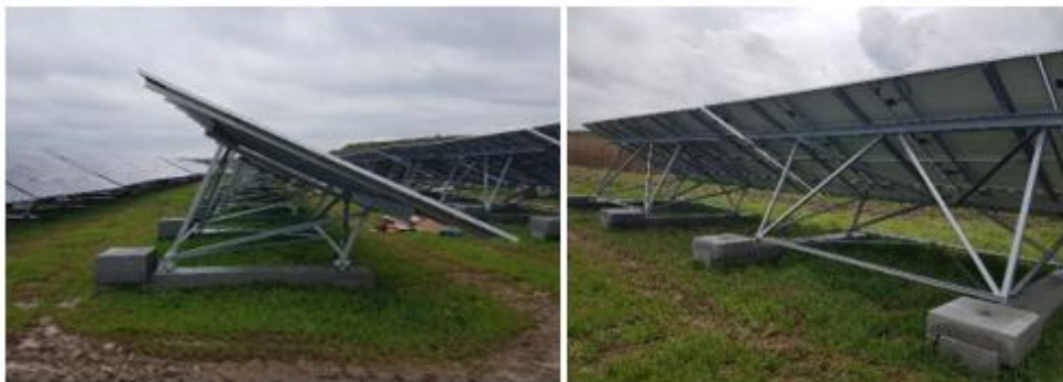
Figure 9: Exemple de fondations béton - Q ENERGY France
